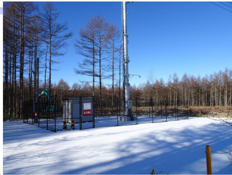
↑ 平成27年12月28日(伐採中)
